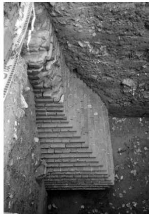
圖 59(左)：普羅民遮堡東側偏南處之磚造壁體，下部呈現的荷蘭磚造十字砌法特徵，較為連續與完整。來源：本文作者拍攝。
