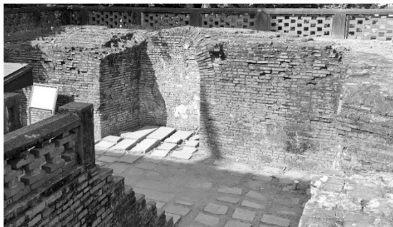
圖 58：東北稜堡內部牆體遺構，雖可辨識出荷蘭磚造十字砌法特徵，但較不連續也較不完整。來源：本文作者拍攝。
