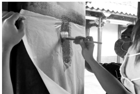
圖 13.以羊毛刷沾附加固劑刷塗
