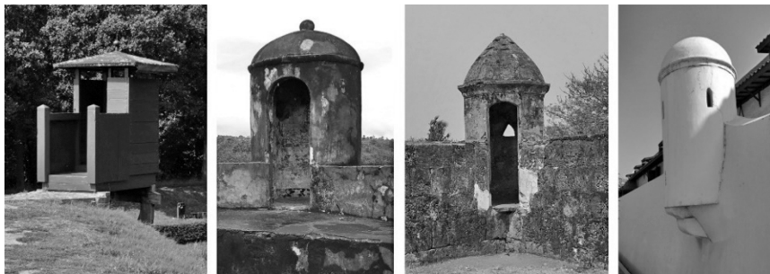
圖 48：由左至右分別為荷蘭要塞城市納爾登（Naarden）的監視塔、印尼薩帕魯阿島（Saparua）杜爾斯泰德堡（Fort Duurstede）的監視塔、印尼爪哇萬丹（Banten）斯佩爾瓦克堡（Fort Speelwijk）的監視塔、以及印尼雅加達海事博物館（前荷蘭東印度公司倉庫建築）外牆的監視塔。來源：本文作者拍攝。
