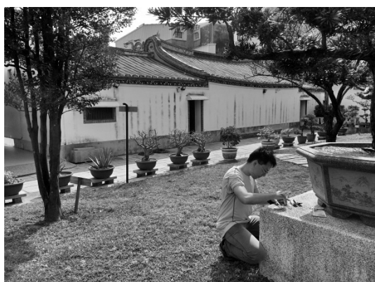
圖 20 基準點鋼標埋設
