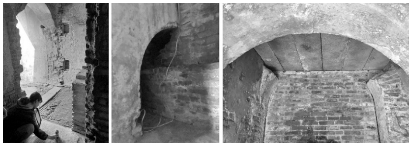
圖 33：赤崁樓基座西側大門內部的拱頂遺構；最右邊照片呈現，裡面拱頂上部已被截斷，上面蓋有石板。來源：本文作者拍攝。
