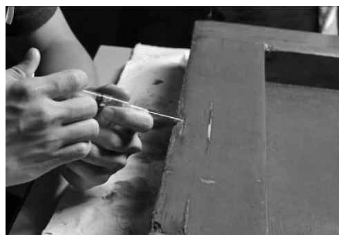
圖 52.剝離幅度大者，以針筒注射加固溶液
