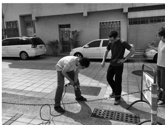
圖 19 鑽孔後埋設鋼標
