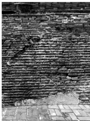
圖 59(左)：普羅民遮堡東側偏南處之磚造壁體，下部呈現的荷蘭磚造十字砌法特徵，較為連續與完整。來源：本文作者拍攝。
