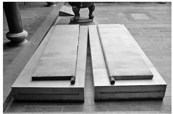
圖 21.拆卸門板靜置
