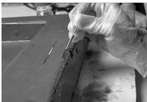
圖 51.單彩剝離處以加固溶液粘合
