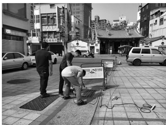
圖 18 埋設鋼標前置作業
